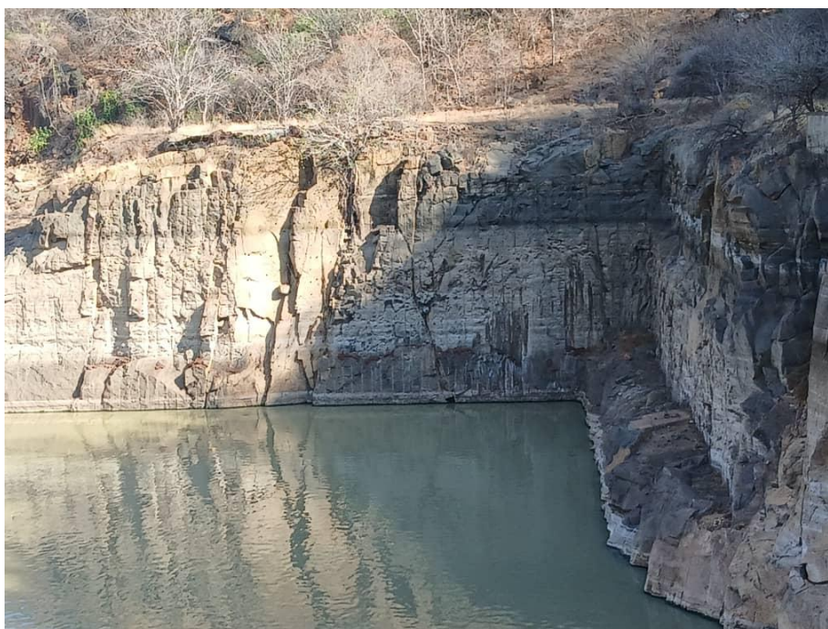
Figura 10-8: Perfil Rochoso Inconsistente na Tomada de Água da CBN
